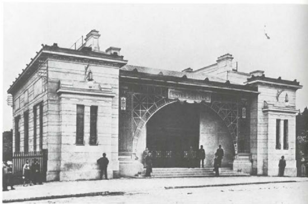
21 Stationsgebäude Unter-Döbling (Architekt Otto Wagner), 1895–1896
